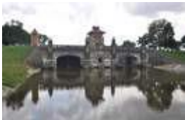
Malá vodní elektrárna
